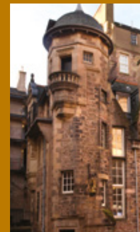
Casa di Lady Stair © EWH
